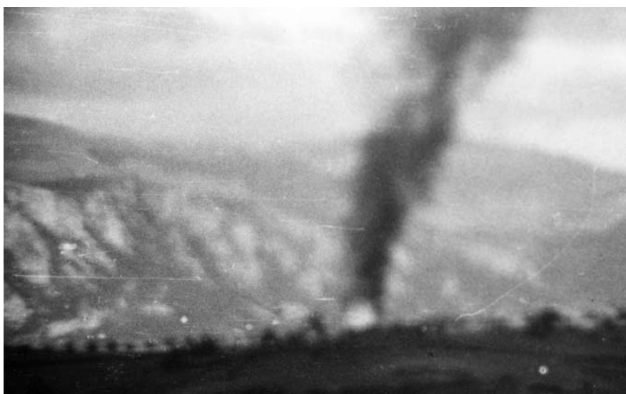
Berane, ottobre 1943 – Brucia il primo aereo italiano atterrato all'aeroporto di fortuna. La foto, scattata da Gorazde, appartiene alla collezione di Lando Manucci
